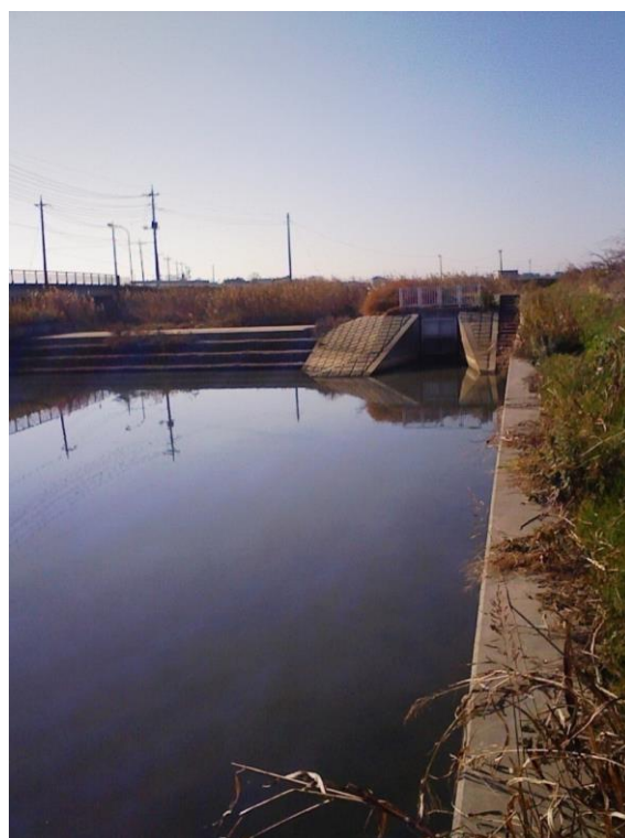
(20) 堰堤：長野落しバイパス側
