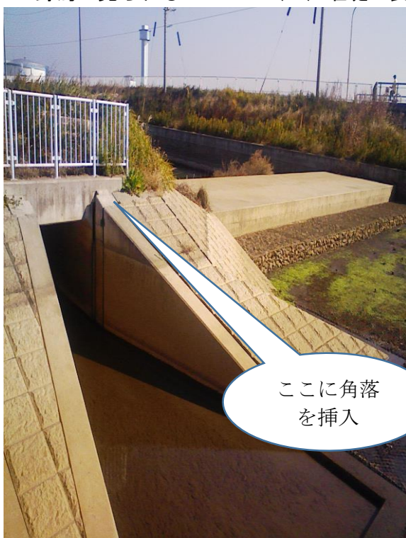
(21) 堰堤：旧忍川側
