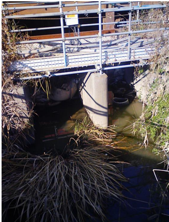
(5) 旧忍川伏越出口（武蔵水路工事中）
